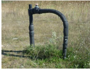
Figure 6. Tête de puits isolée pour l'hiver
