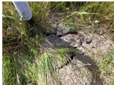
Figure 8. Couvert imparfait laissant l'oxygène pénétrer et le méthane s'échapper
