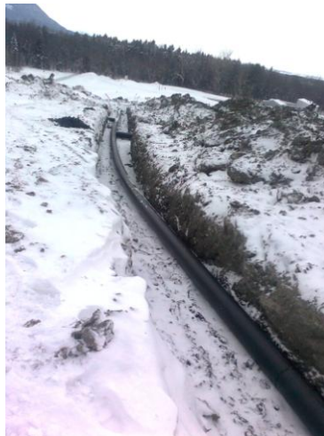
Figure 7. Pose souterraine de conduite de collecte
