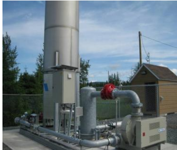
Figure 3. Vue d'ensemble de la plateforme de combustion et du bâtiment
